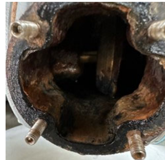
※排水弁の汚れ（取付前）
